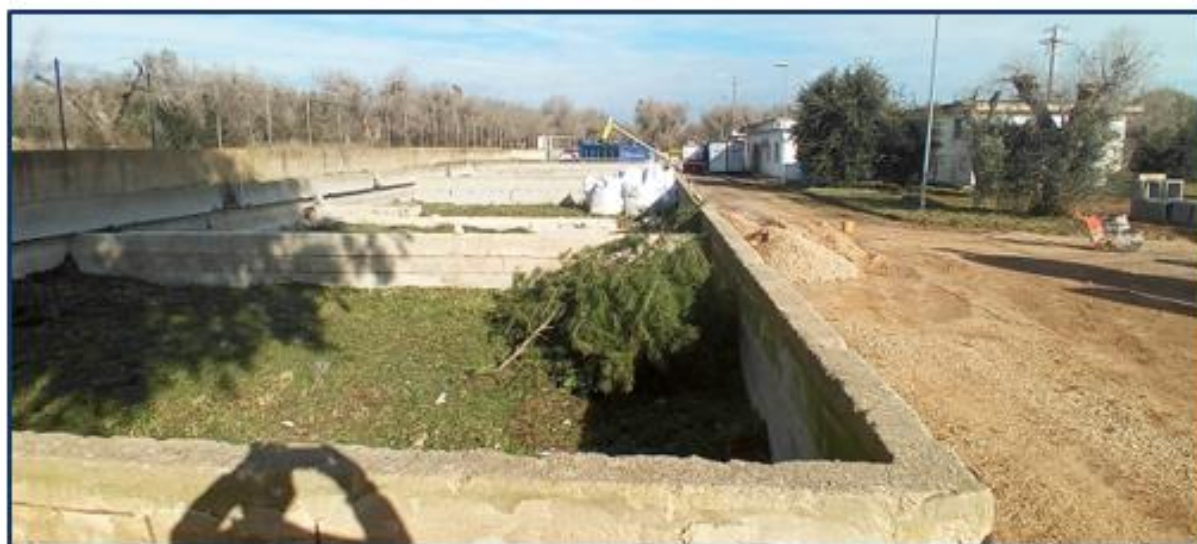
Foto 4 _Letti di essiccamento da demolire
