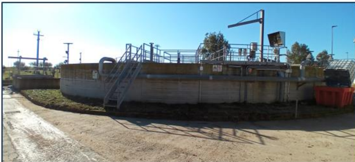
Foto 1 _Attuale vasca di sedimentazione secondaria da rifunzionalizzare
